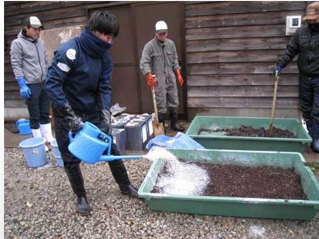
天然ゴムを混合 水道水で希釈した天然ゴム を混合する
