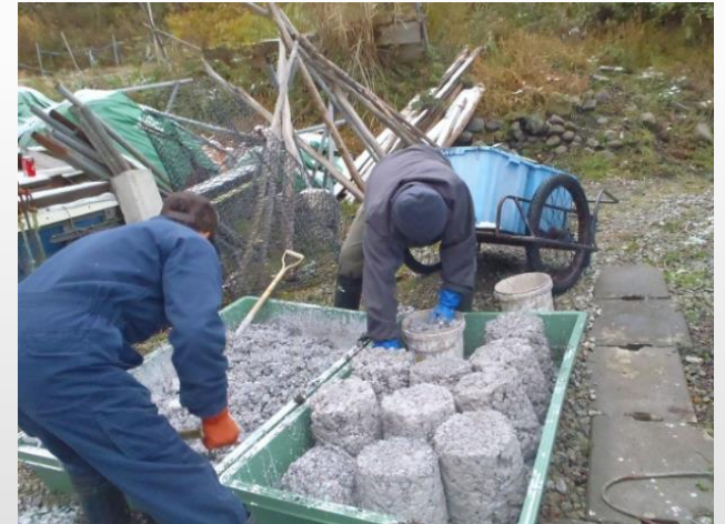
成型乾燥固化 バケツ等の容器に入れて 成型後自然乾燥させる
